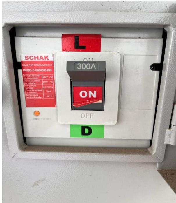
Imagem 03 – Disjuntor geral do ponto de medição
