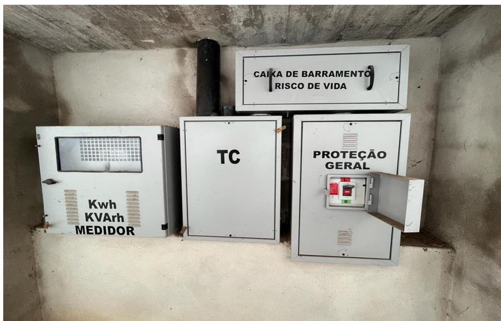
Imagem 02 – Foto do medidor de energia
